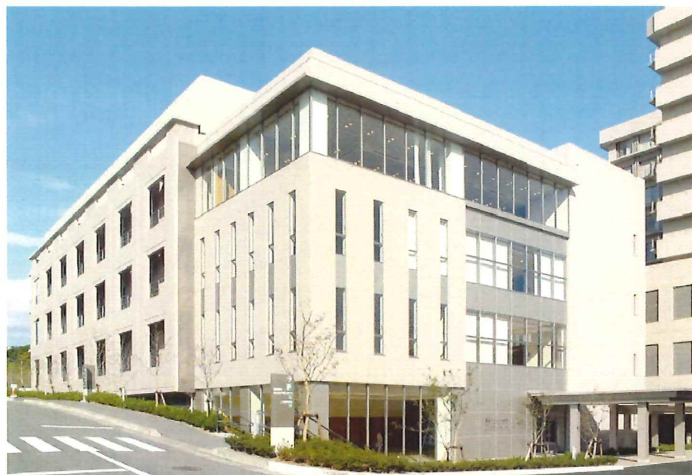
新築された研究所棟 (2005年11月)
