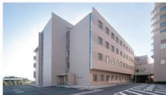
新築された新管理棟（2009年11月）
