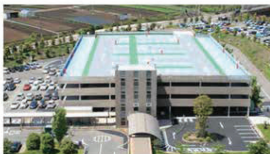
立体駐車場完成（2009年4月）
