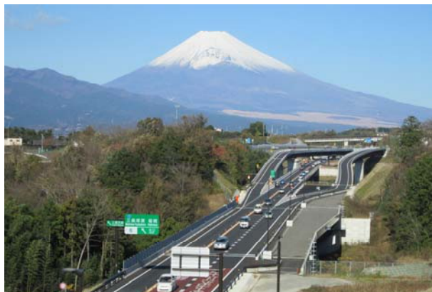
伊豆縦貫自動車道の整備
